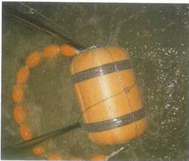
N市西部下水処理場 流量調整槽設置風景 2000m 3 槽 2基 SH-1000 4台設置 AIR量 1m 3 /min×4台=4m 3 使用目的 下水腐敗防止及び負荷軽減
