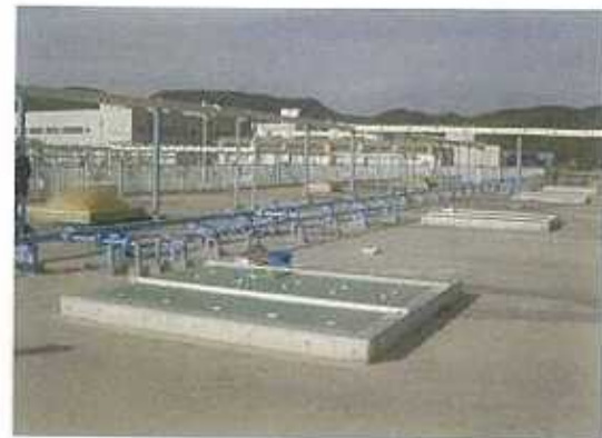
N市西部下水処理場 流量調整槽設置風景 2000m 3 槽 2基 SH-1000 4台設置 AIR量 1m 3 /min×4台=4m 3 使用目的 下水腐敗防止及び負荷軽減
