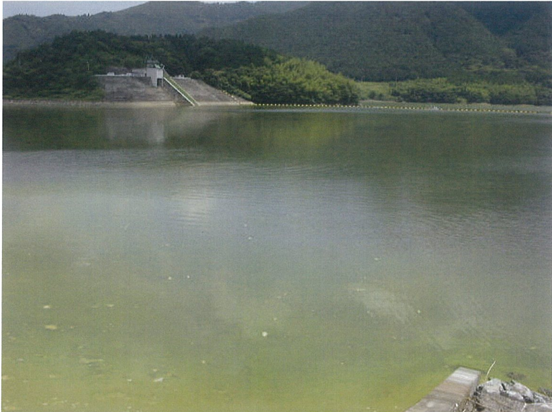
設置前風景 撮影平成 12 年 7 月 19 日
